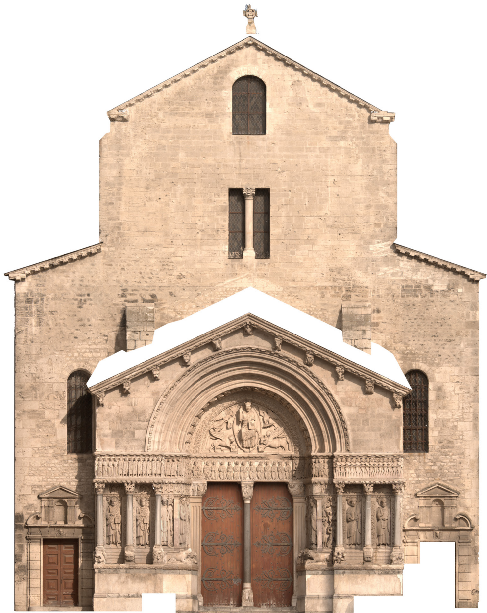
Fig.15 - Orthophotographie complète de la façade.
